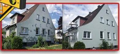
Wenn der alte Putz reißt oder bröckelt, sollte der Hausbesitzer nicht lange mit einer Sanierung warten. Risse und Löcher in der Fassade sind nicht nur unschön, sie können langfristig schwere Schäden zur Folge haben, weil der Außenputz das Mauerwerk nicht mehr ausreichend vor Feuchtigkeit und Umwelteinflüssen schützen kann. Aber keine Sorge, um dabei höhere Kosten zu vermeiden, lohnt es sich einen Experten von uns zu rufen und den Schaden langfristig zu beheben.
